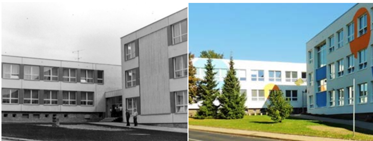
Obrázok 4: Stav objektu pred a po rekonštrukcii (zdroj: https://www.litomerice.cz/aktuality/zakladni-skola-u-stadionu-sviti-novotou )
