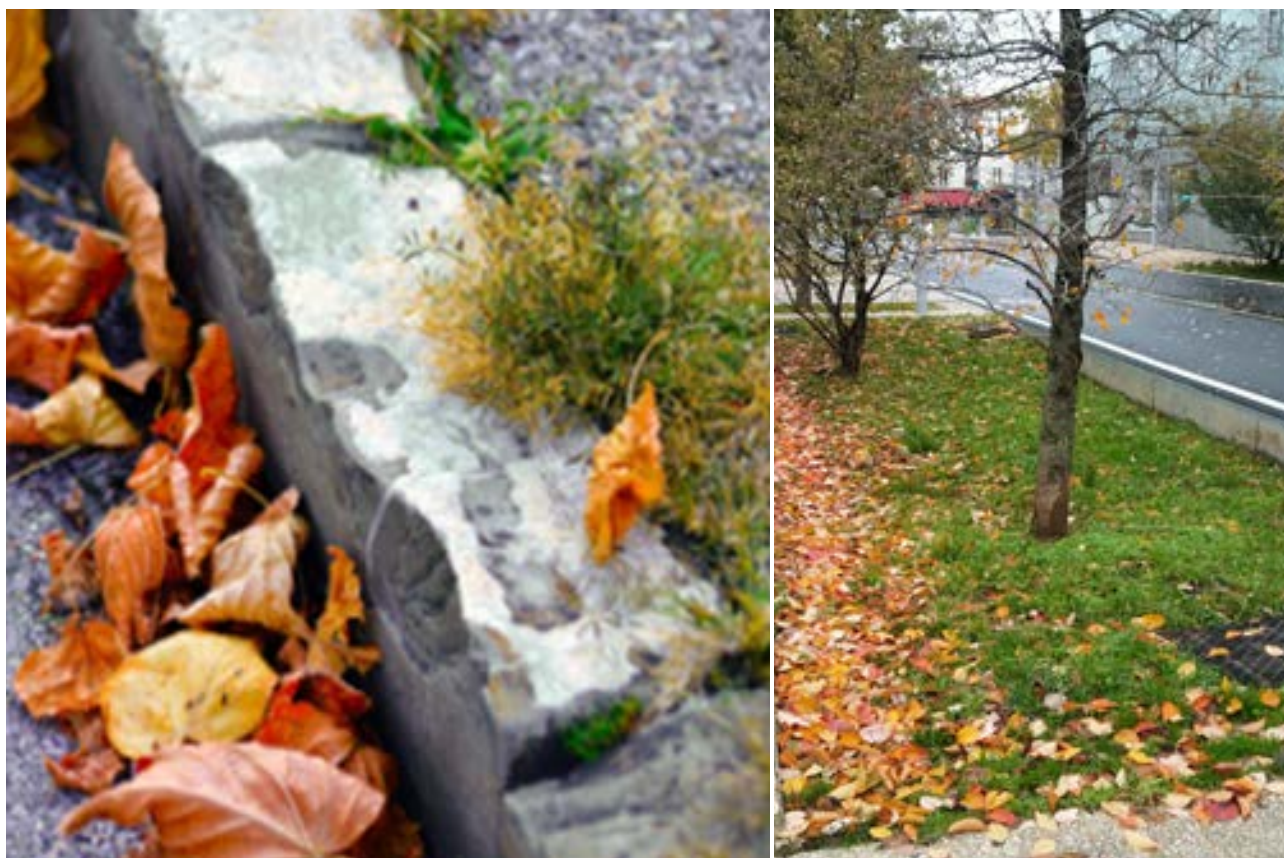
Obrázok 8: Obrubník, ktorý neumožňuje a je prekážkou pri vsakovaní zrážkovej vody z komunikácie (Autor: Ing. Zuzana Hudeková PhD.)
