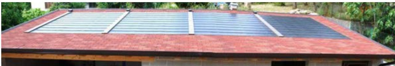
Obrázok 9: Ukážka panelov umiestnených priamo na ploche (zdroj: Jarás: Opatrenie-Inštalácia strešnej FVE)
