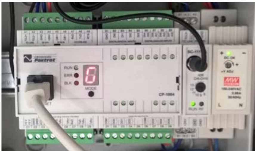
Obrázok 4: Bezdrôtové riadenie svetelného toku svetidiel VO pomocou centrálnej riadiacej jednotky, tu Tecoma Foxtrof, v rozvádzači VO (zdroj: PORSENNA o.p.s.)
