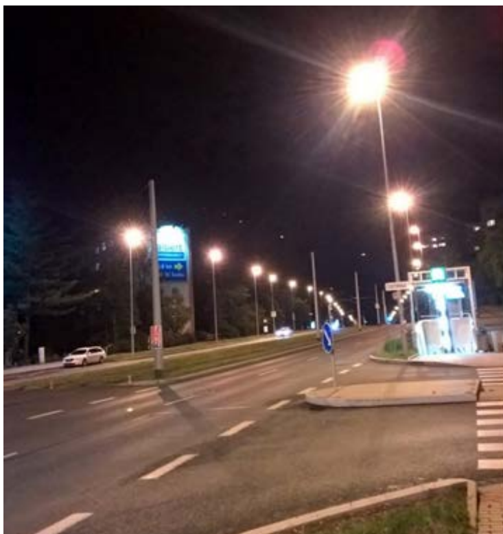
Obrázok 5: Mestské tranzitné úseky ponúkajú vysokú mieru využitia regulácie svetelného toku počas noci, keď je motorová doprava na minimálnej úrovni. Na obrázku je sústava VO s vysokotlakovými sodíkovými výbojkami (foto: Theodor Terrich)
