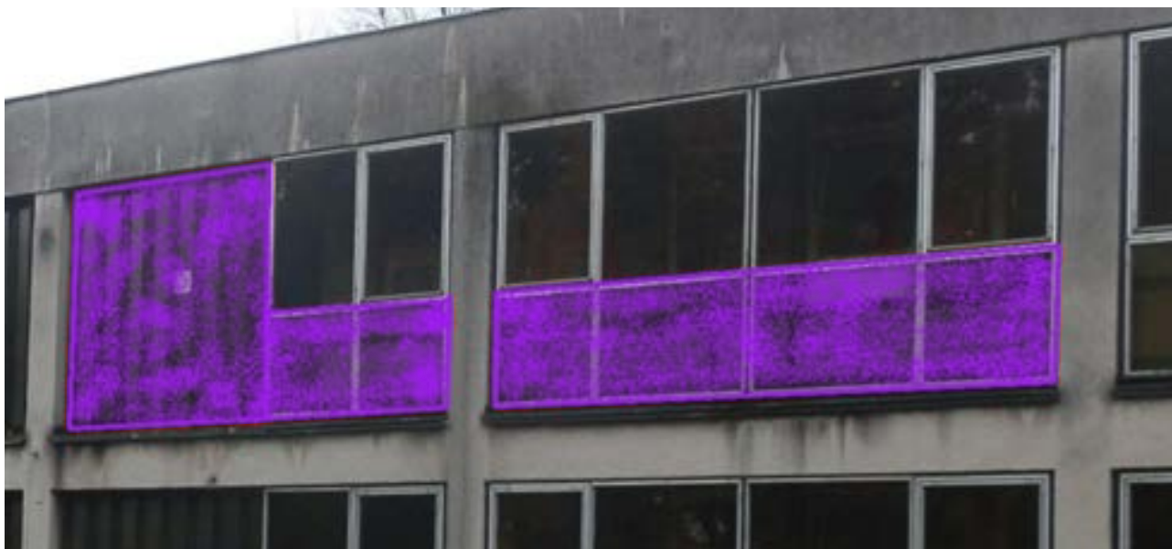
Obrázok 2: Príklad možnej redukcie presklenej plochy v mieste vykurovanej chodby (zdroj: PORSENNA o.p.s.)
