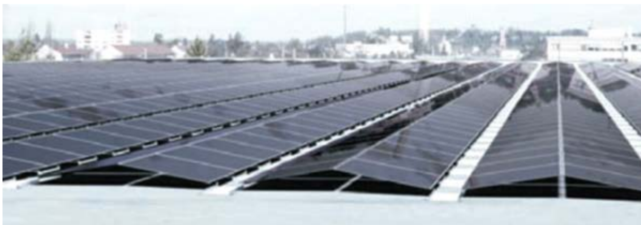
Obrázok 10: Ukážka konštrukcie východ-západ (zdroj: Jarás: Opatrenie-Inštalácia strešnej FVE)
