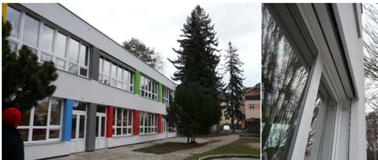
Obrázok 6: Stav MŠ po rekonštrukcii, vpravo detail osadenia predokenných žalúzií (zdroj: PORSENNA o.p.s.)
