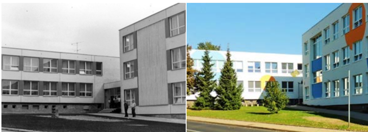
Obrázok 8: Stav objektu pred a po rekonštrukcii (zdroj: https://www.litomerice.cz/aktuality/zakladni-skola-u-stadionu-sviti-novotou )
