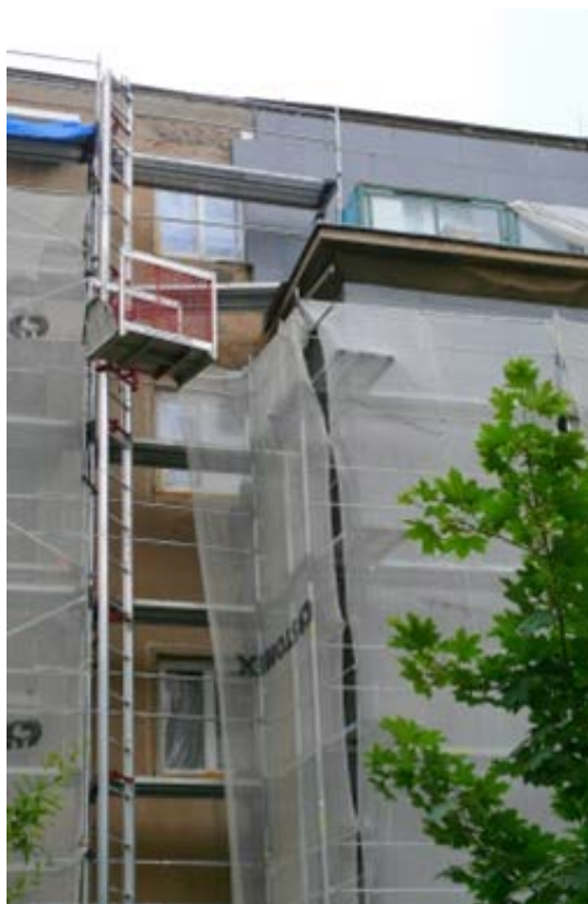
Obrázek 1: Zateplení objektu (zdroj: PORSENNA o.p.s.)
