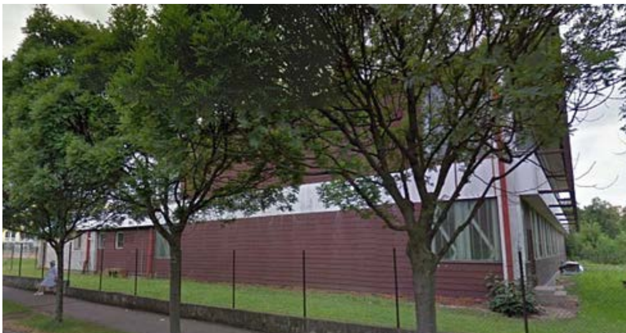
Obrázek 7: Stávající stav sportovní haly BIOS (zdroj: https://www.kolin.cz/sportovni-halu-bios-ceka-kompletni-rekonstrukce-i-energeticka-uspore )
