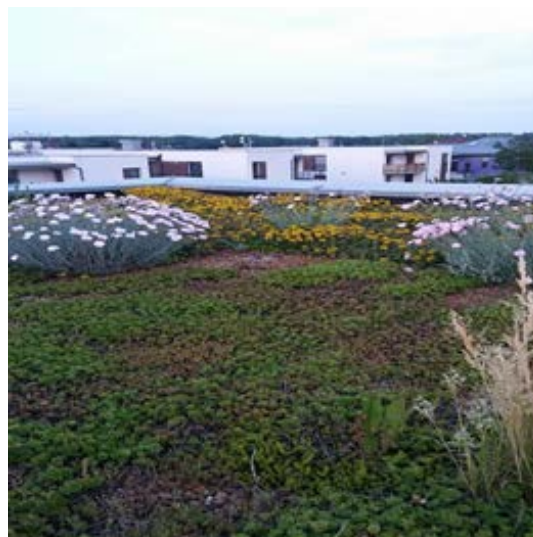
Obrázek 1: I na extenzivní vegetační střeše je možné kombinovat rozchodníky s nenáročnými skalničkovými trvalkami a trávami (zdroj: Zuzana Hudeková)
