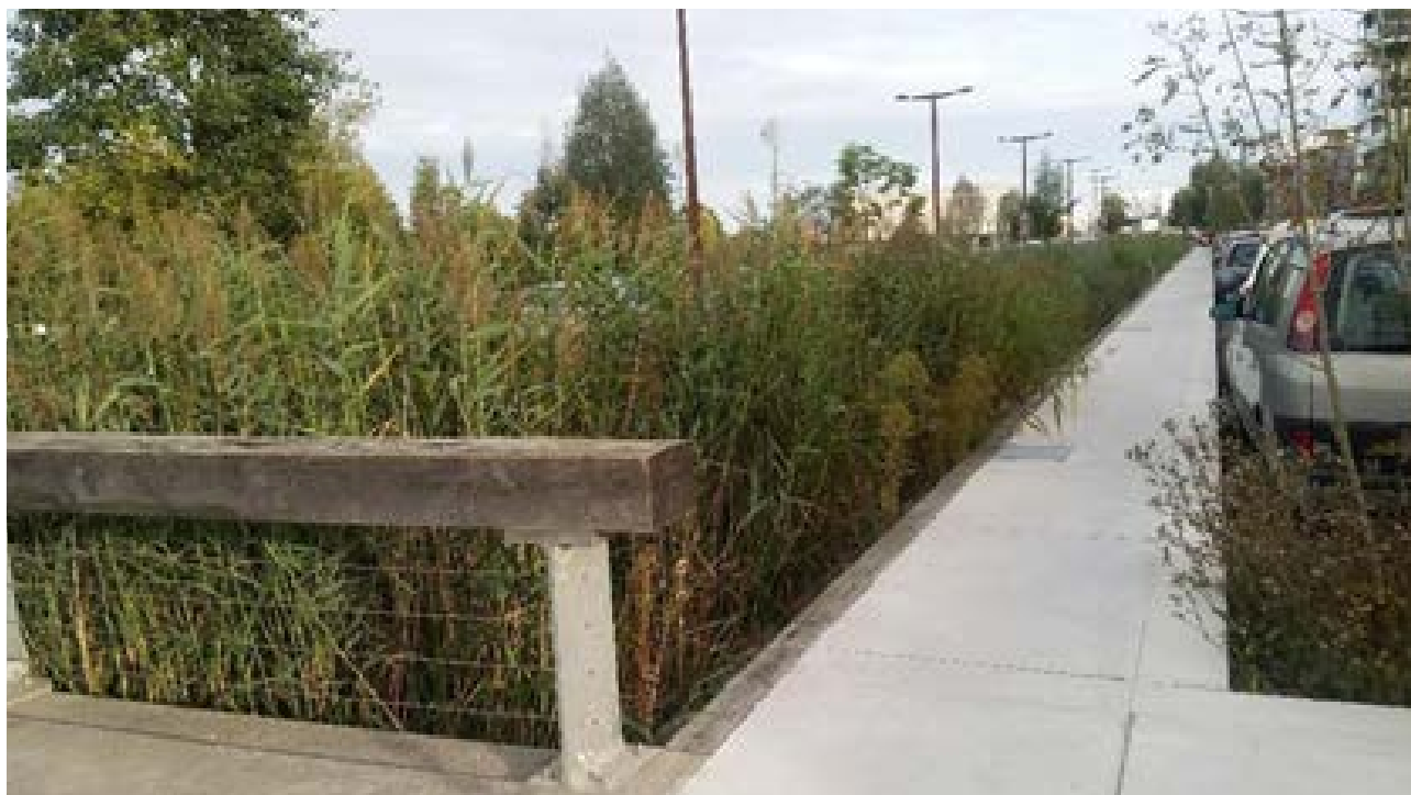
Obrázek 10: Vsakovací a retenční plocha v urbanizovaném prostředí (zdroj: Zuzana Hudeková)
