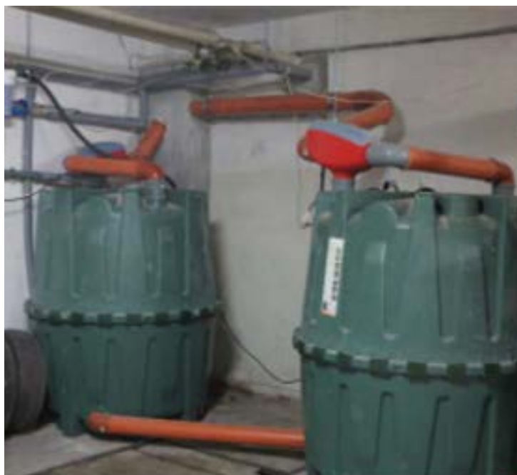
Obrázek 6: Zásobníky na dešťovou vodu (zdroj: https://myzvolen.sme.sk/c/20628047/zvolen-zadrziava-vodu-chce-inspirovat-ine-mesta.html )
