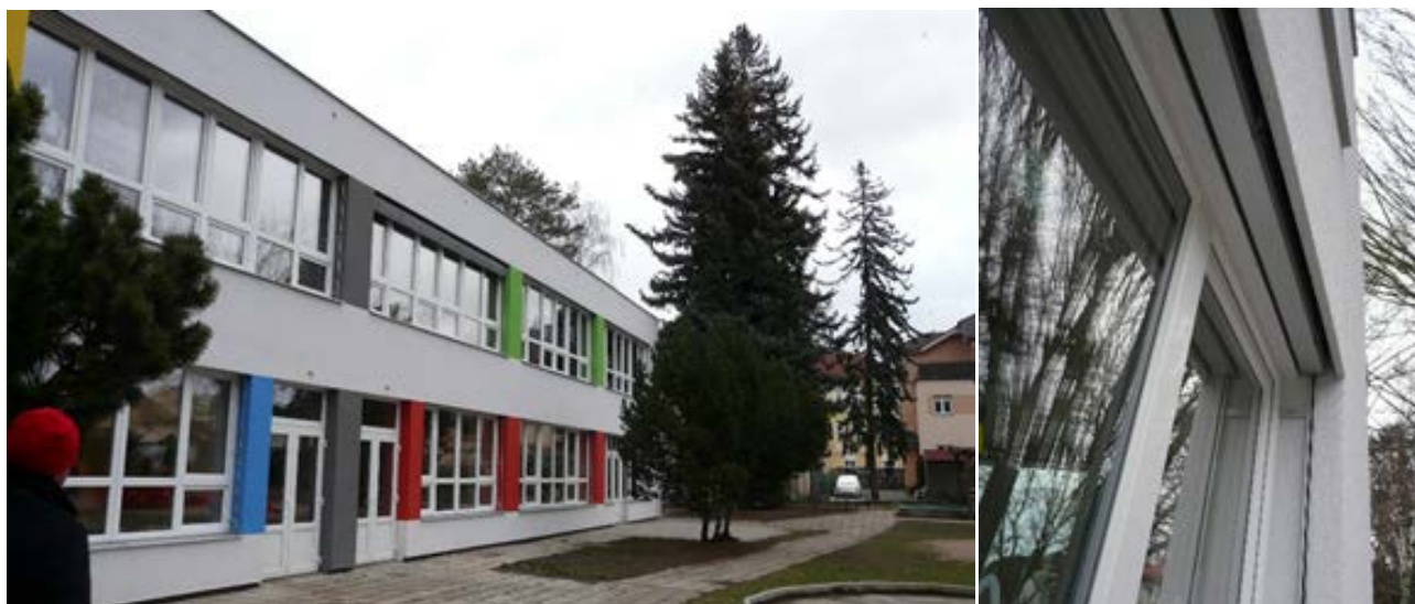
Obrázek 6: Stav MŠ po rekonstrukci, vpravo detail osazení předokenních žaluzií (zdroj: PORSENNÁ o.p.s.)
