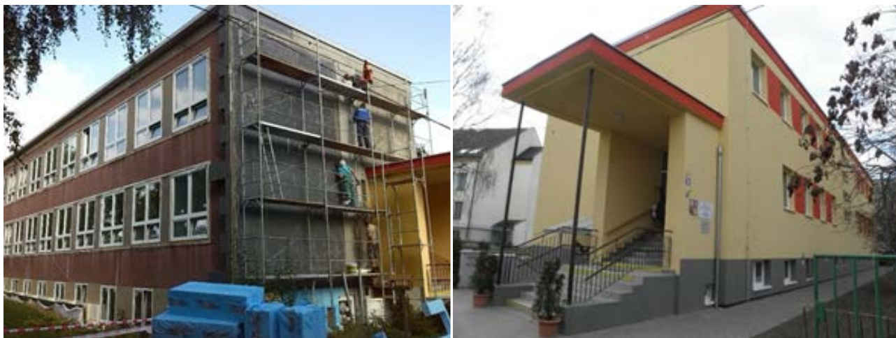
Obrázek 3: Stav objektu před a po renovaci (zdroj: PORSENNA o.p.s.)
