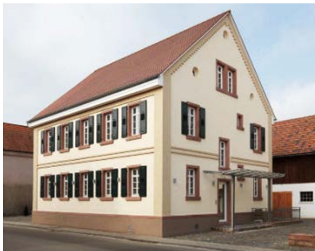
Obrázek 2: Renovace kancelářské budovy, Rimbach (zdroj: https://passivehouse-database.org/#d_3961 )
