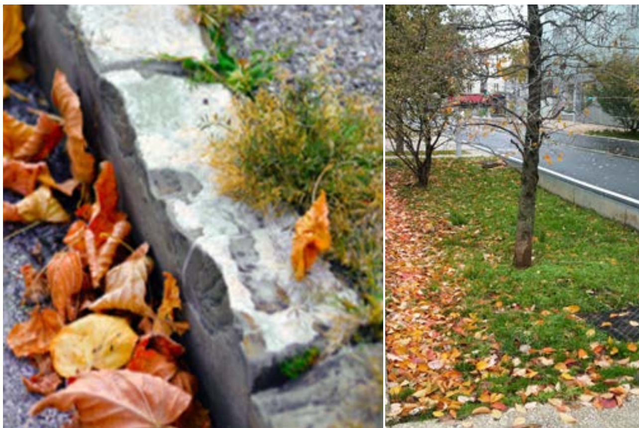
Obrázek 8: Obrubník je překážkou při vsakování srážkové vody z komunikace (zdroj: Zuzana Hudeková)
