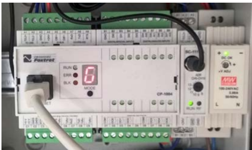
Obrázek 4: Bezdrátové řízení světelného toku svítidel VO pomocí centrální řídicí jednotky, zde Tecomat Foxtron, v rozvaděči VO (zdroj: PORSENNA o.p.s.)
