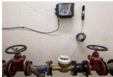
Obrázek 13: IoT senzory instalované k fakturačním odběrným místům (zdroj: https://automatizace.hw.cz/vyuziti-technologie-iot-pro-energeticky-management-budov.html )
