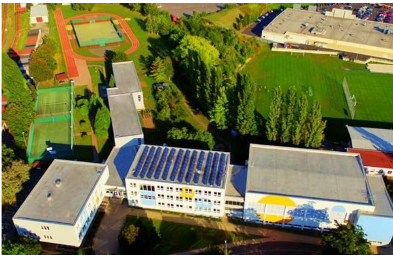
Obrázek 6: Nová podoba objektu s instalovanou FVE (zdroj: https://mapy.cz/zakladni?x=14.1438341&y=50.5373563&z=17&source=firm&id=358067&gallery=1 )
