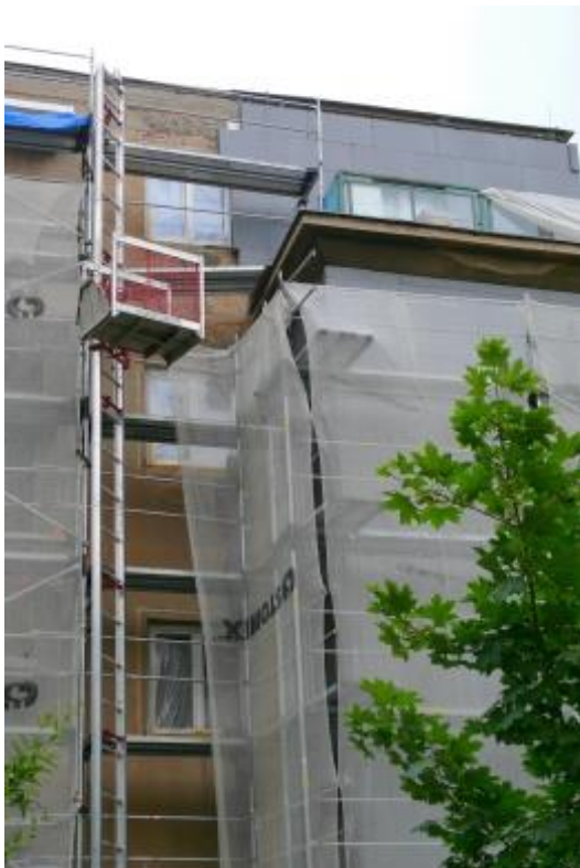
Obrázek 1 Zateplení objektu (zdroj: vlastní)
