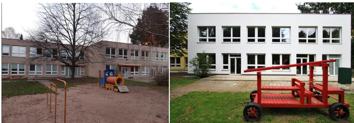
Obrázek 2 Před realizací a po realizaci projektu (zdroj: vlastní)
