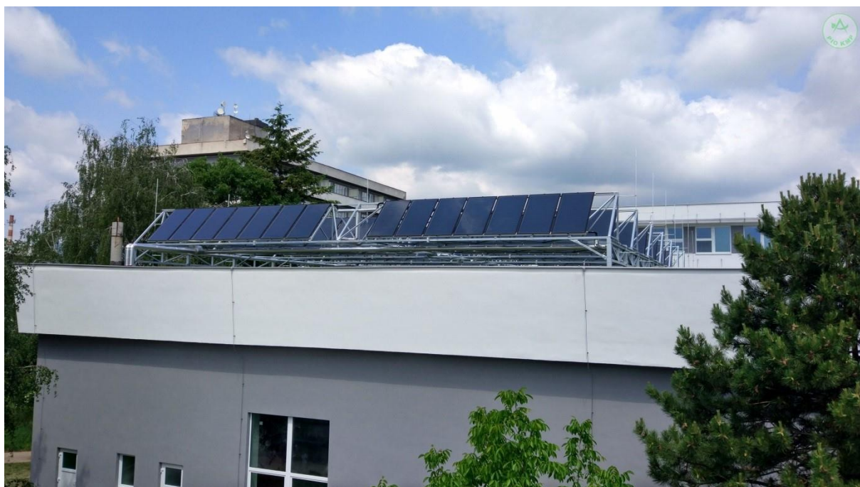
Obrázek 6 - Fototermické panely na střeše bazénu
