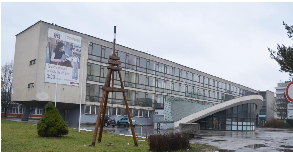
Obrázek 4 - Původní stav objektu
