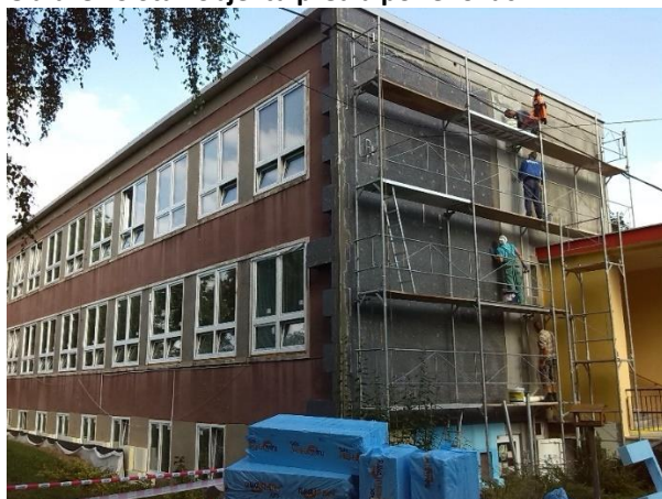
Obrázek 3 Stav objektu před a po renovaci
