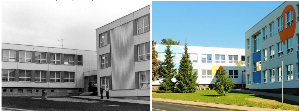
Obrázek 4 - Stav objektu před a po rekonstrukci
