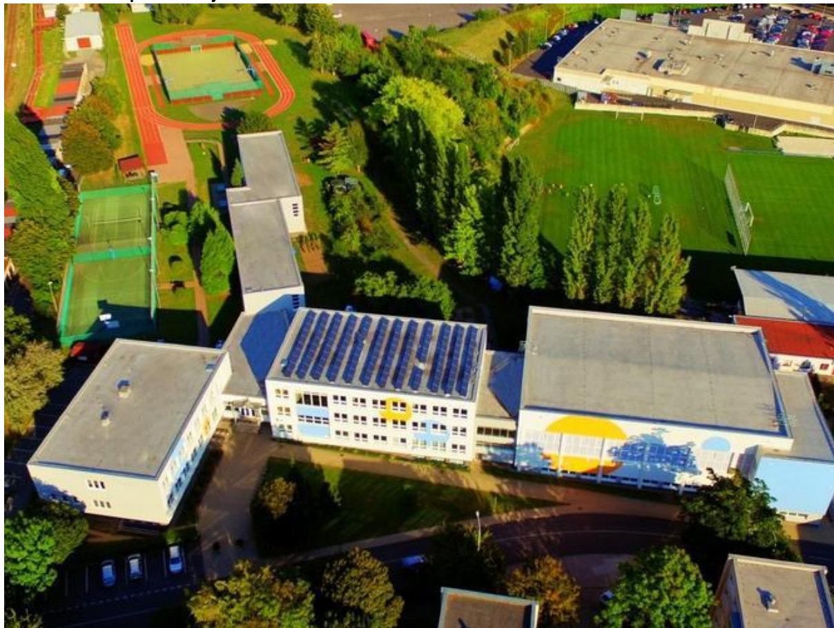
Obrázek 6 Nová podoba objektu s instalovanou FVE
